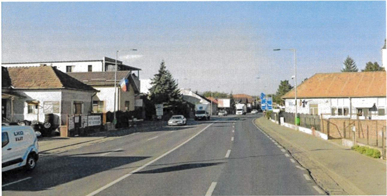
Figura 15. Foto strada Avram Iancu, tronson M. Kogălniceanu - Cetății
