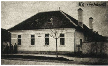
Primăria (demolată în 2012)
