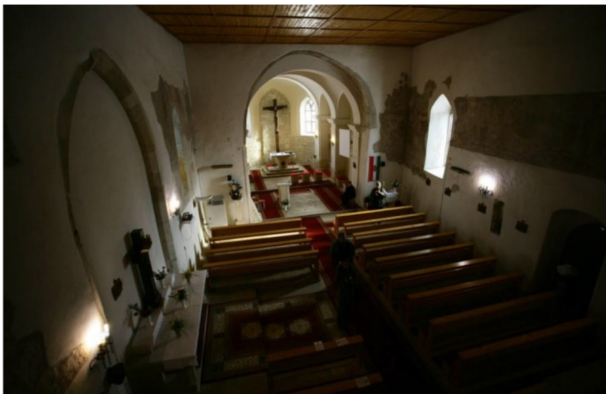
IMAGINE DE INTERIOR A BISERICII ROMANO-CATOLICE DIN FLOREȘTI – SE POATE OBSERVA TURNUL – PĂSTRAT NETENCUIT ȘI CU PIATRA DE TALIE MONTATĂ PE MUCHII, RESPECTIV TAVANUL RESTAURAT, CU ÎNCHIDERE DIN SCÂNDURI DE LEMN. DE ASEMENEA SE POT OBSERVA INTERVENȚIILE DE FACTURĂ BAROCĂ, GRAȚIE ARCELOR TIP MÂNER DE COȘ.(2010).
