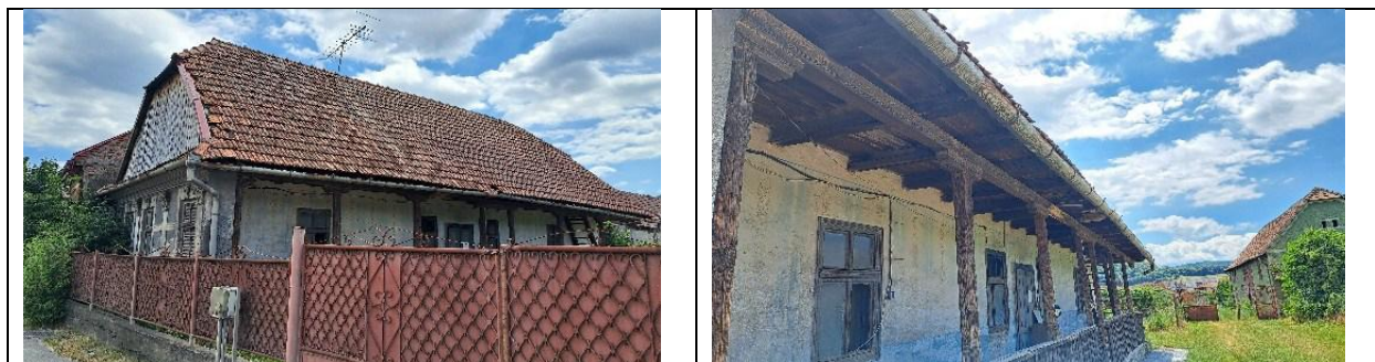
Fig. 33 Locuință str. Avram Iancu nr. 212
