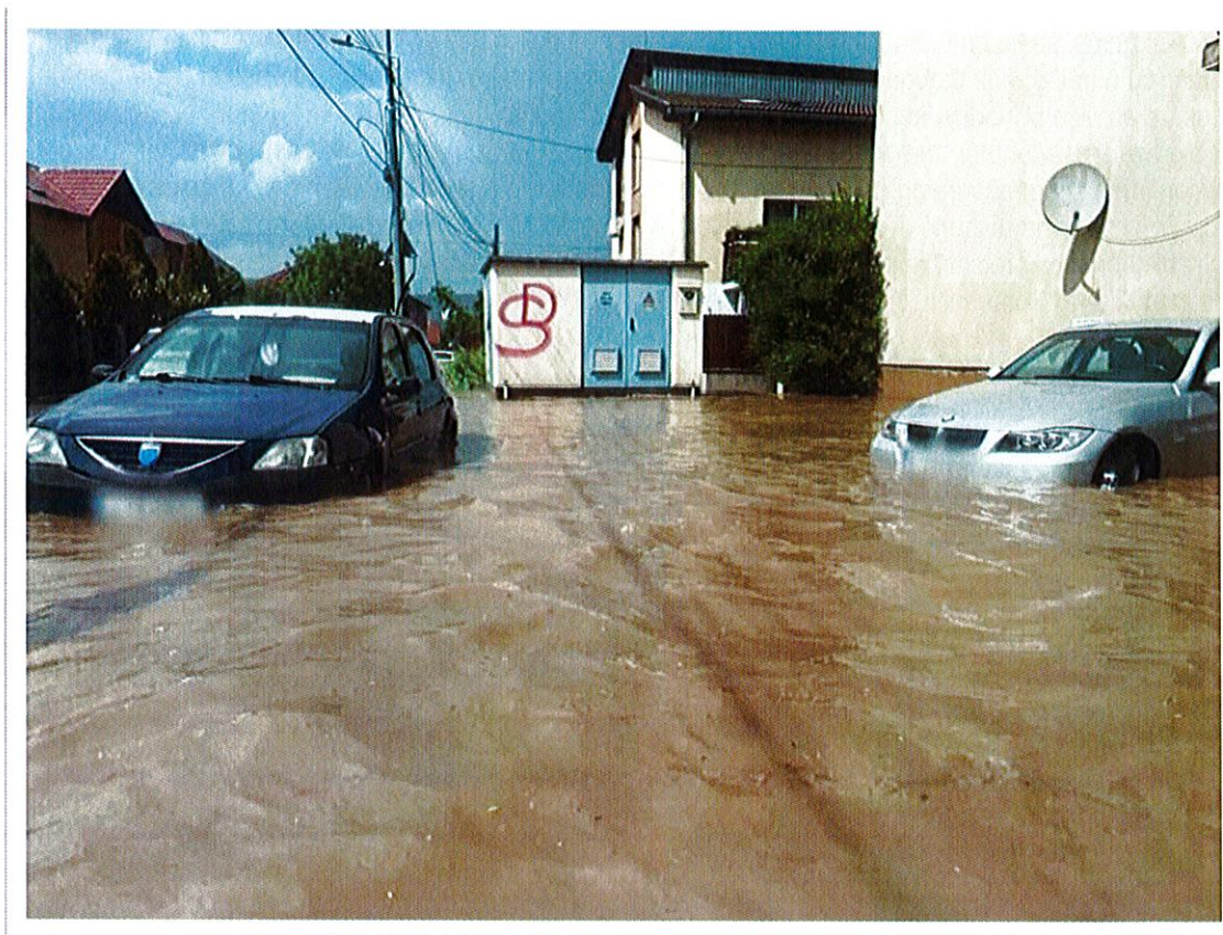
Figura 11. Efectul unor căderi masive de ploi la nivelul unor zone insuficient gestionate urbanistic și care nu au fost dotate corespunzător din punct de vedere tehnico-edilitar 15
