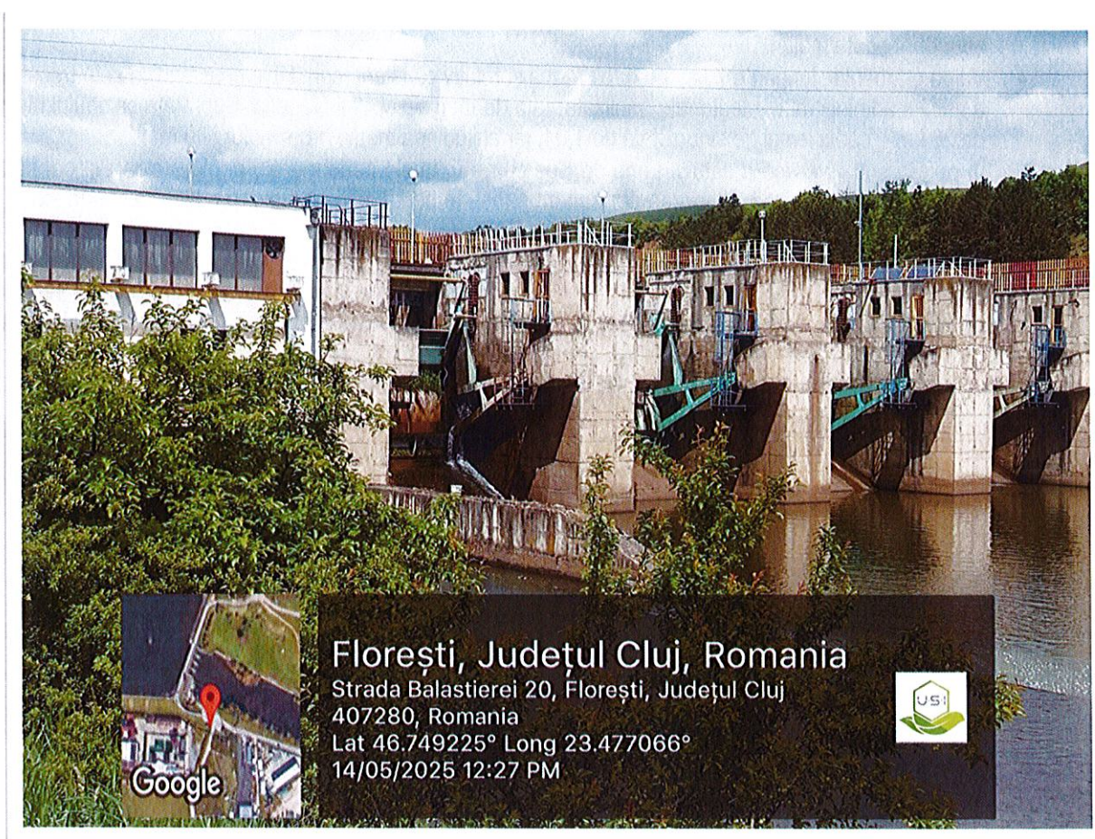
Figura 9. Aspect al Hidrocentralei Florești II
