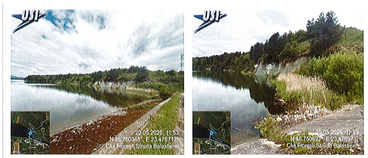
Figura nr. 44. Lacul de acumulare al Hidrocentralei Florești II
