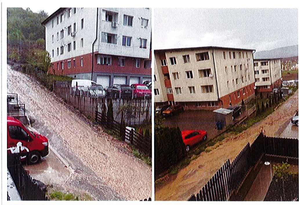
Figura 10. Aspect al deficiențelor cauzate de căderi masive de ploi la nivelul unor zone insuficient gestionate urbanistic și care nu au fost dotate corespunzător din punct de vedere tehnico-edilitar 12
