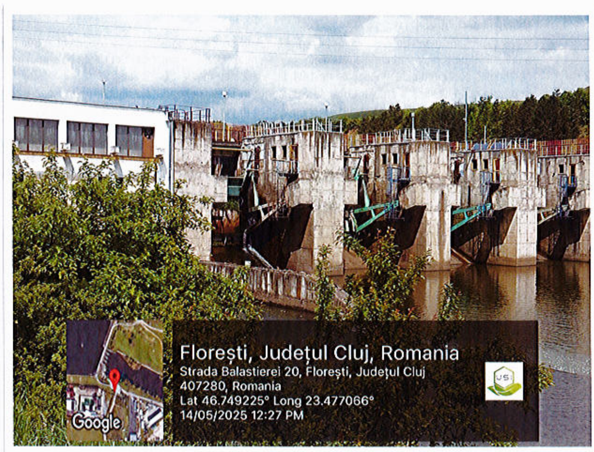
Figura 9. Aspect al Hidrocentralei Florești II
