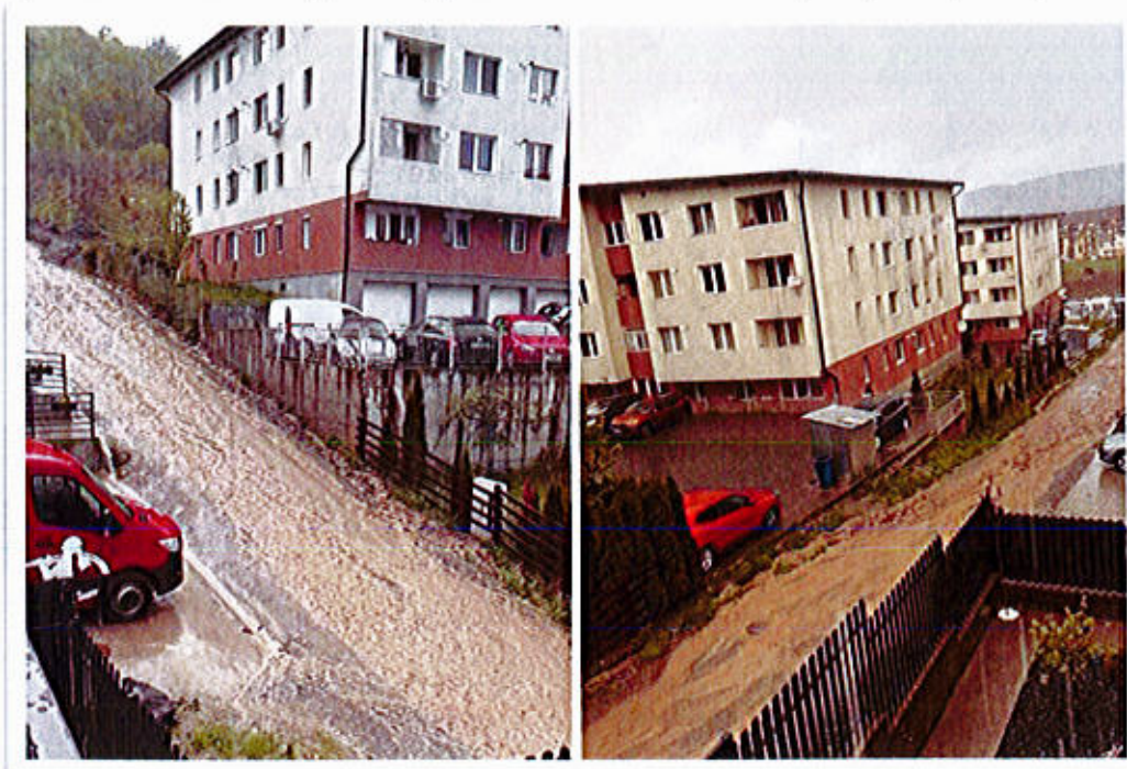
Figura 10. Aspect al deficiențelor cauzate de căderi masive de ploi la nivelul unor zone insuficient gestionate urbanistic și care nu au fost dotate corespunzător din punct de vedere tehnico-edilitar 14
