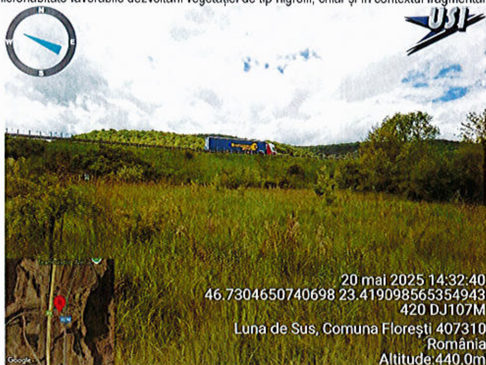
Figura 70. Zonă adiacentă autostrăzii A3
