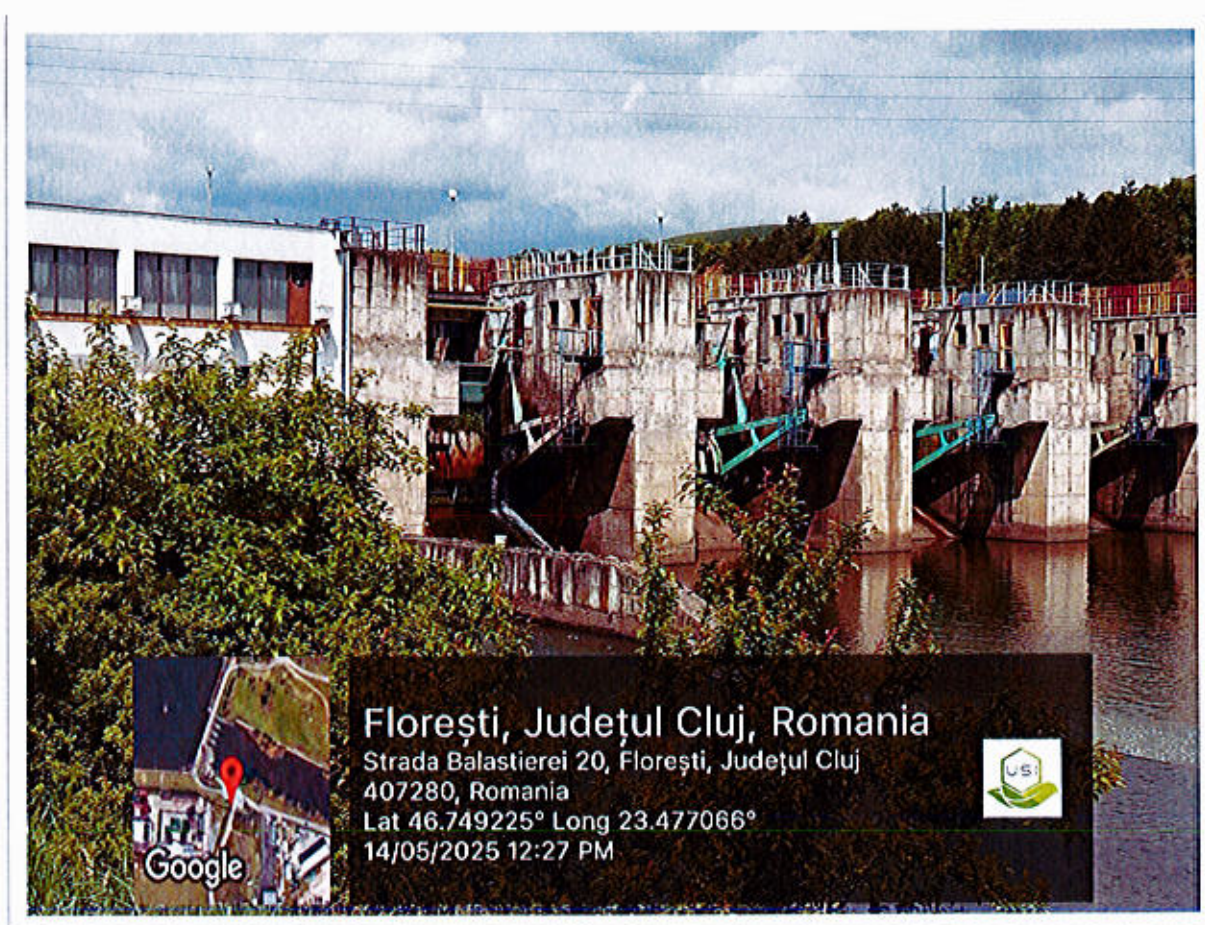
Figura 9. Aspect al Hidrocentralei Florești II
