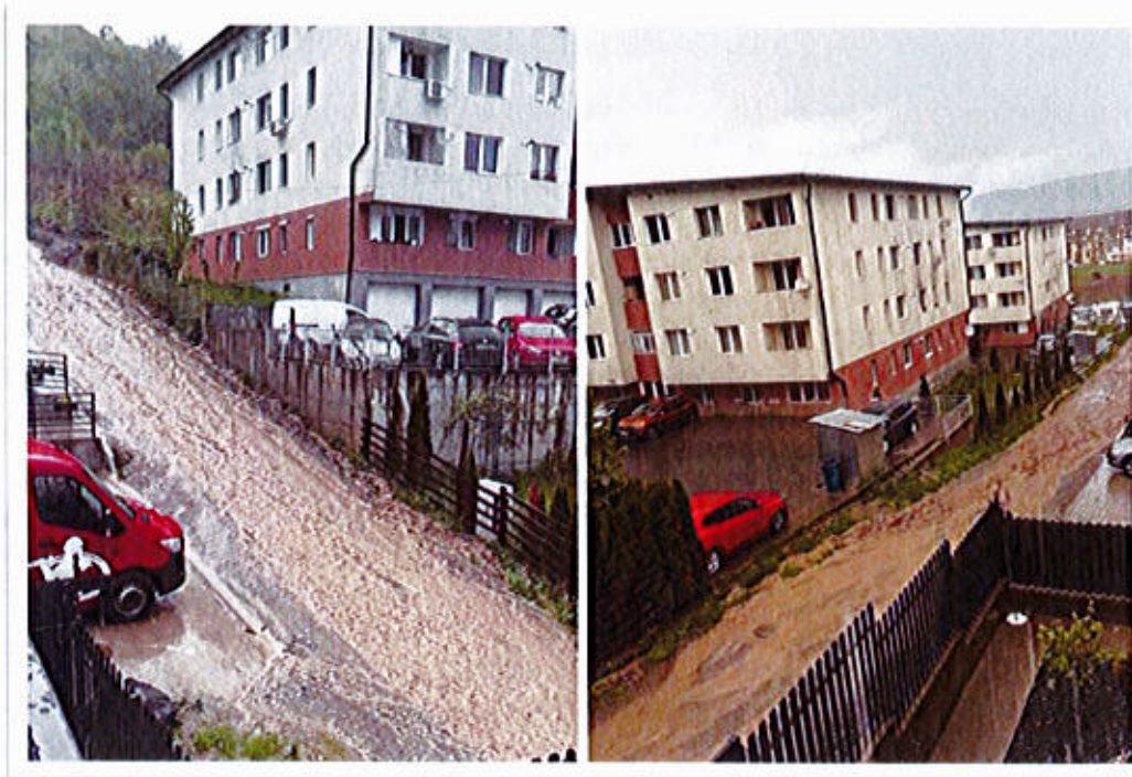
Figura 10. Aspect al deficiențelor cauzate de căderi masive de ploi la nivelul unor zone insuficient gestionate urbanistic și care nu au fost dotate corespunzător din punct de vedere tehnico-edilitar 13
