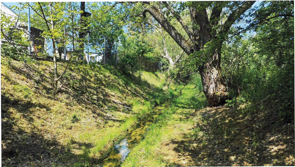
Tronson al râului Pe Vale regularizat și întreținut corespunzător de către riverani
