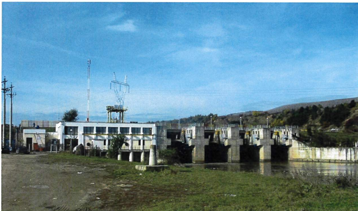
CHE si barajul Floresti II(sursa: https://www.hidroconstructia.com/dyn/2pub/proiecte_det.php?id=121&pg=29 )
