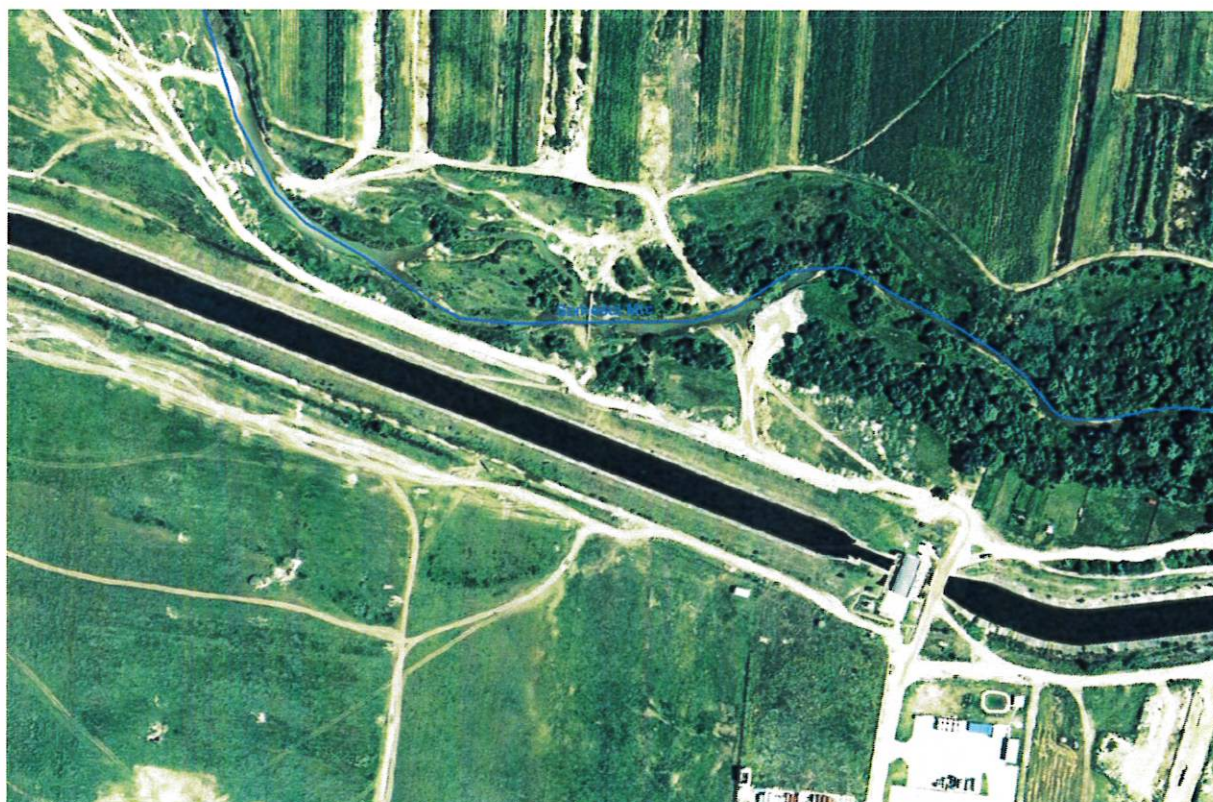
Canalul Someșul Mic și hidrocentrala Florești I
