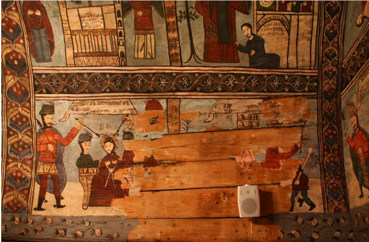
Fig.10.1.51. Interior. zone lipsă ale picturii și instalarea improprie a dispozitivelor de sunet.
