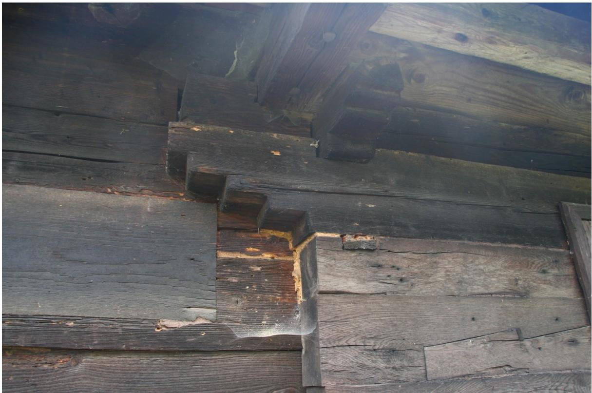
Fig.10.1.41. și Fig. 10.1.42. Elemente decorative exterioare – finisarea consolelor în trepte, cu profiluri variate. In Fig.10.1.43. se pot observa intervențiile de restaurare prin înlocuire a unor segmente ale grinzilor originale degradate.
